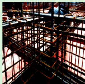
柱内箍及拉筋。落梁前对梁端钢筋数量、级别、规格、梁端加密区长度、梁筋二排主筋长度、位置进行核对,由于梁的截面较大,梁端锚固能满足直锚要求;落梁后钢筋容易偏位,如梁箍筋偏斜、主筋偏位、底部和侧边保护层偏位、二排筋散落,若发生偏位应进行纠偏。待设计要求的箍筋及拉钩都绑扎完毕后,松开临时固定,将框架及箍筋笼一起落下。检查落梁时梁主筋是否有偏位,如有便立即调整。
