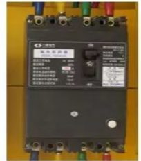
漏电断路器 参考图例 8.14.4—6
