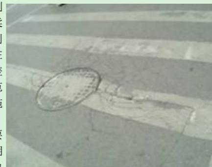
图1 井圈周围路面凹陷开裂
